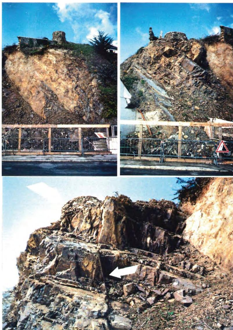
Figure 9 – Photographies extraites du rapport BRGM 89SGN255GEG/BRE (Margron 1989) montrant l'important éboulement survenu en décembre 1988 à l'extrémité est du quai Surcouf à Binic (évènement 62200521 de la base de données BDMVT). Il est à noter que, selon le rapport du BRGM, une grande partie des blocs éboulés avait été purgée avant la prise de ces photographies.
