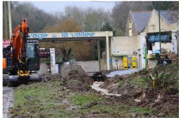
La cause de l'inondation est une buse bouchée d'où, une fois les alluvions dégagées, s'est écoulé un fort débit d'eau. (©La Presse d'Armor)
