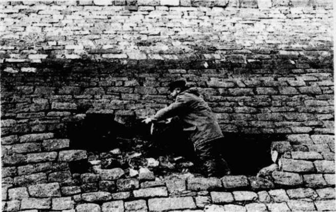
**Eplanade de l'avant-port :** dalles gravillonnées soulevées et déplacées sur plusieurs zones (environ 200 m<sup>2</sup>) ; rembarde des escaliers d'accès à la plage couchées, voire arrachées ; plaque d'enrobée déplacée face aux sanitaires.
