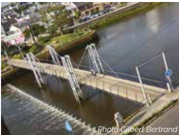
Platelage de la passerelle
